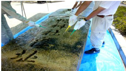
石材の石材強化剤含浸作業 (藤井寺市教育委員会)
